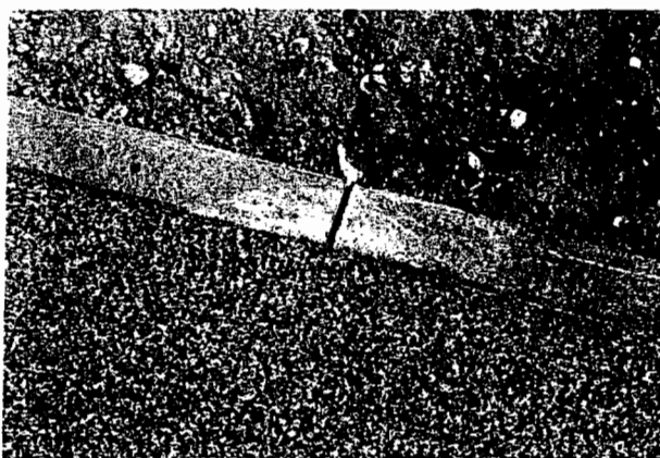
Wykończenie nawierzchni zwykłymi obrzeżami trawnikowymi.
